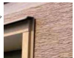
**MOULURE DE JOINT DE 30 MM :** Il permet de réaliser la jonction en bout entre deux lames et d'assurer l'étanchéité.
